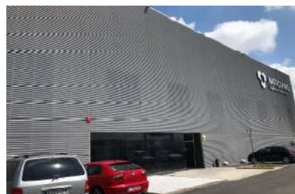
Imagen de la nave
