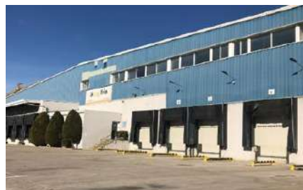
Imagen de la nave
