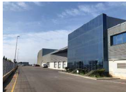
Imagen de la nave
