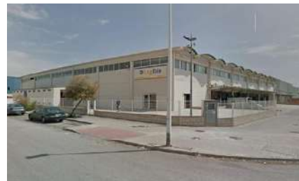
Imagen de la nave
